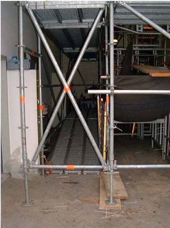
(1) Eingang zur Strecke
