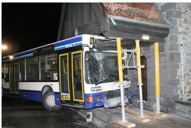
Bild 03 – Der Bus hat durch den Aufprall die beiden Steinsäulen herausgedrückt und sich zwischen den Fundamenten und dem Dach eingeklemmt.
