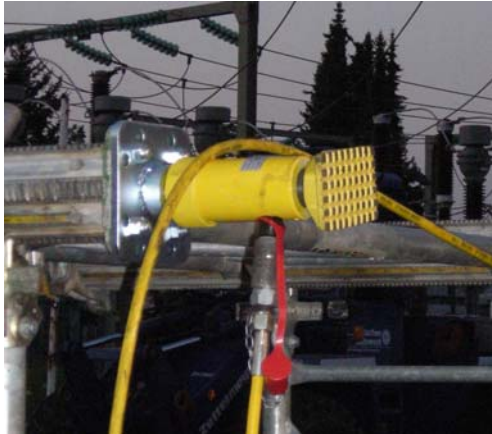
Bild 04 – Systemplatte mit eingeschraubtem Hebestempel – kraftschlüssig mit 4 Schrauben mit der Stütze verschraubt.
