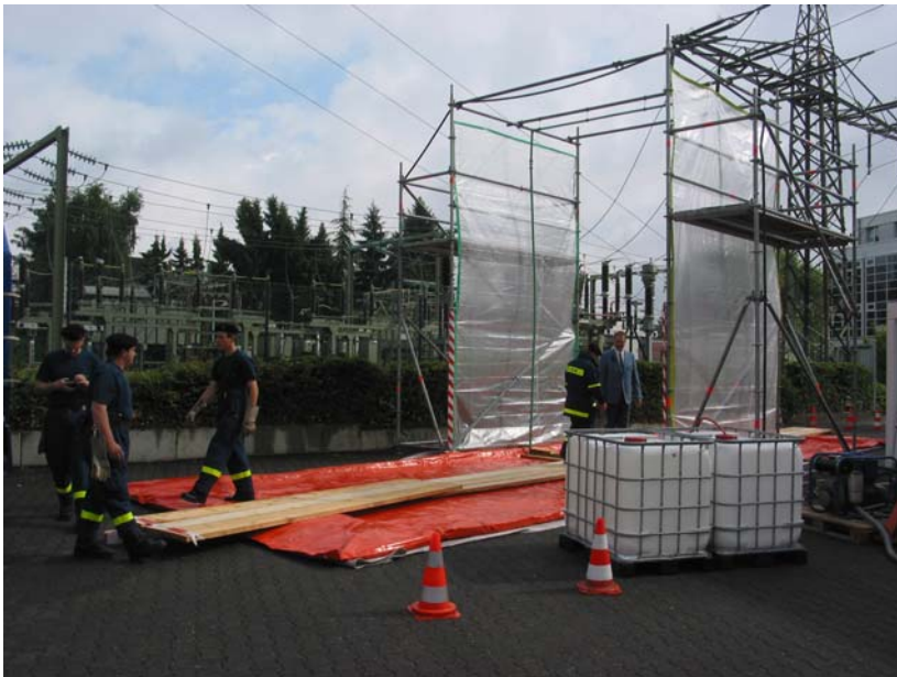
Bereits am Eingang wurden den Besuchern eine MKS Anlage gezeigt
