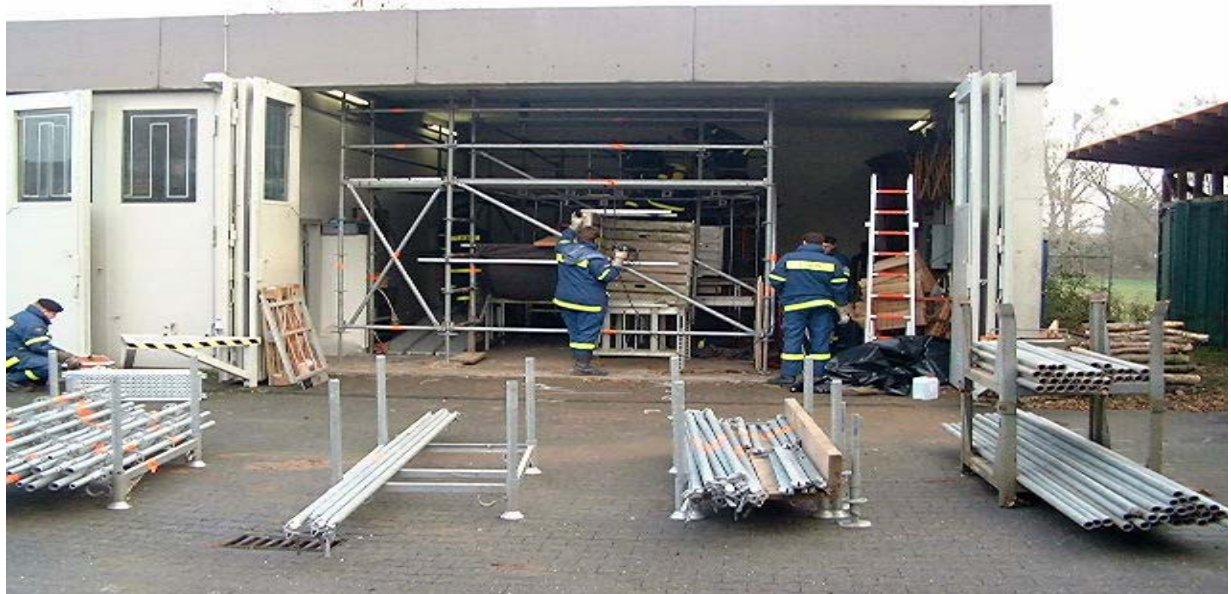
(7) Abbau des der Übungsstrecke
