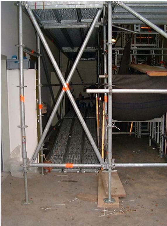
(1) Eingang zur Strecke
