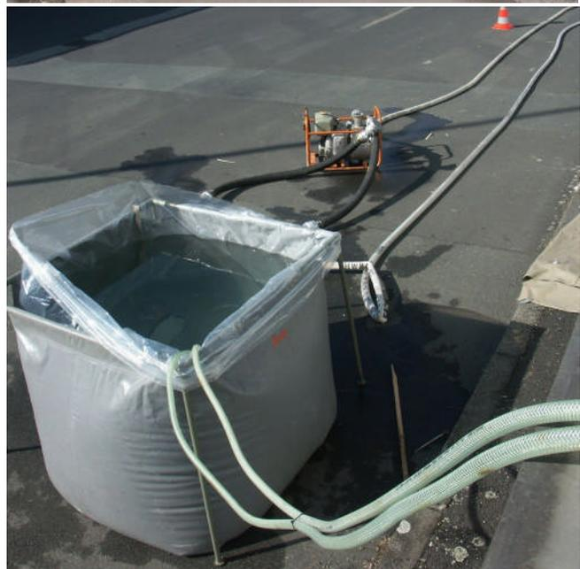
**Die Wasserversorgung der Betonkettensäge und des Kernbohrgeräts.**
