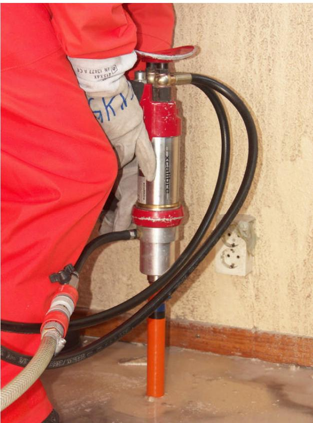
**Schaffung der Erkundungsöffnung mit dem Kernbohrgerät.**
