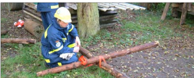
Verbinden zweier gekreuzter Rundhölzer mit dem Spanngurt
