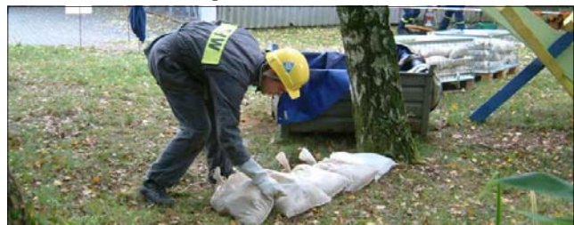
Verlegen von Sandsäcke
