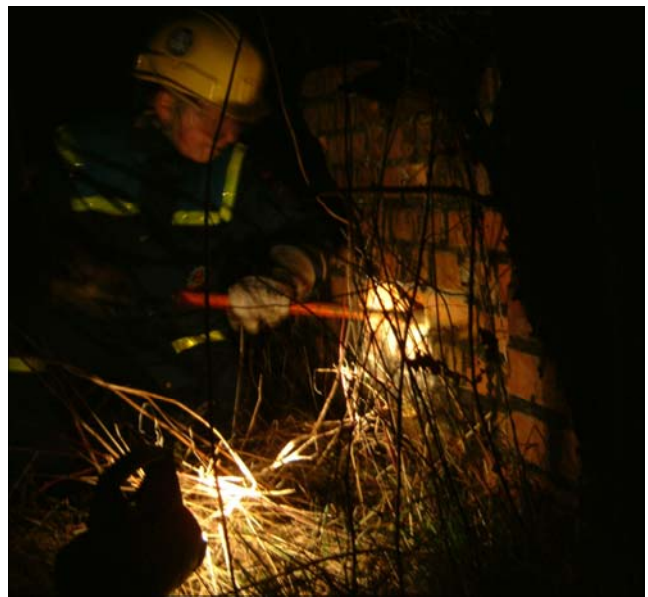
Wanddurchbruch mit Hammer und Meißel
