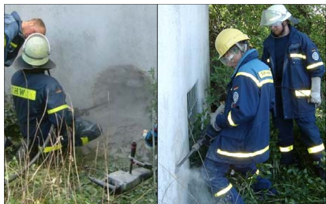
Schaffen der Öffnung mittels Presslufthammer/ -bohrer
