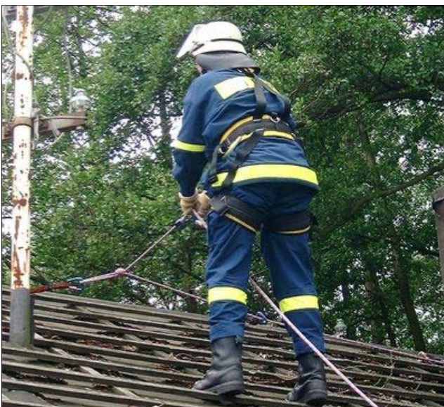
Bewegen auf dem Dach mittels Steigklemme
