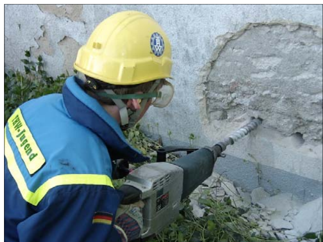
Verwendung verschiedener Arbeitstechniken für das Schaffen der Rettungsöffnung
