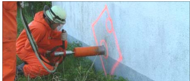
Kontaktbohrung mit dem Kernbohrgerät
