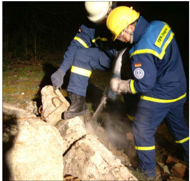
Gesteinsbearbeitung mit dem Bohr- und Aufbrechhammer
