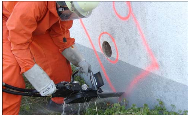
Einsatz der Betonkettensäge, nach der Kontaktbohrung
